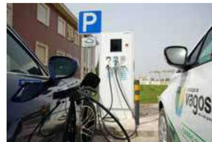
De acordo com João Paulo Sousa, vice-presidente da Câmara, o novo posto “permite o carregamento em 50 kilowatts, em corrente contínua (DC), e em 43 kilowatts, em corrente alternada (AC), sendo que possibilita dois carregamentos em simultâneo, podendo estar um veículo em DC e outro em AC”.
